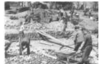
1959: Freiwillige Helfer und Angehörige der Deutschen Grenzpolizei bei Schachtarbeiten für den Bau von Stallanlagen der LPG „Bergland“
